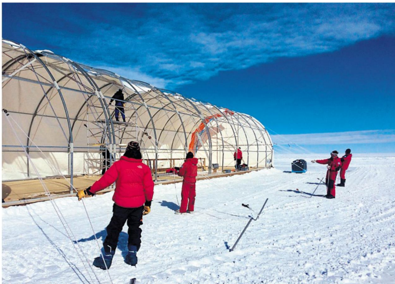
1 L'équipe du projet européen «Beyond Epica» installe, en juin 2019, le couvercle de la structure hébergeant le système de forage de la glace.
